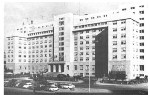
El segundo edificio de Vialidad Nacional - Retiro
